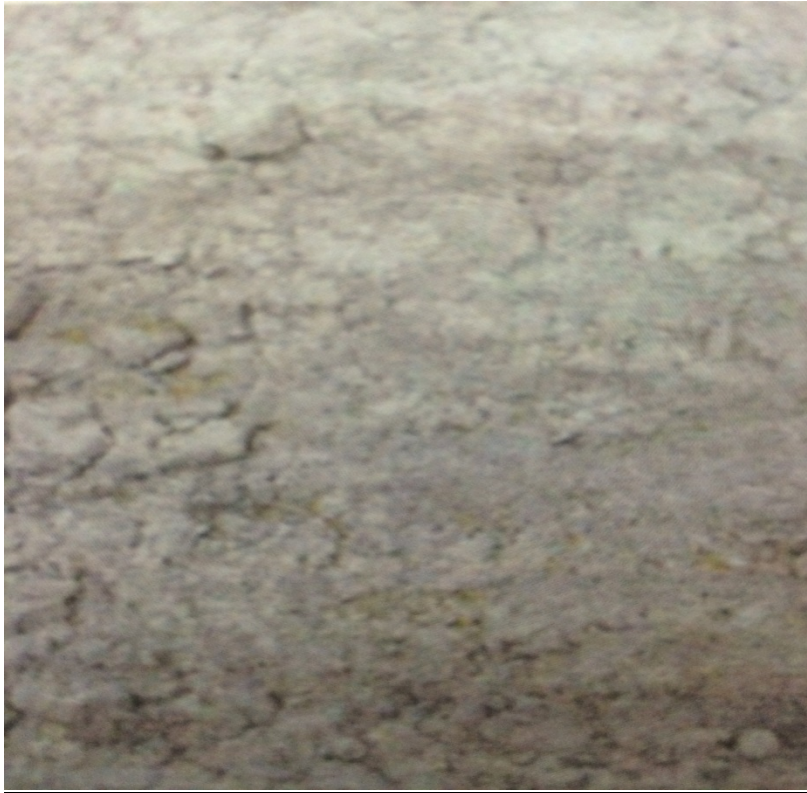
Superficie externa antes de la limpieza
